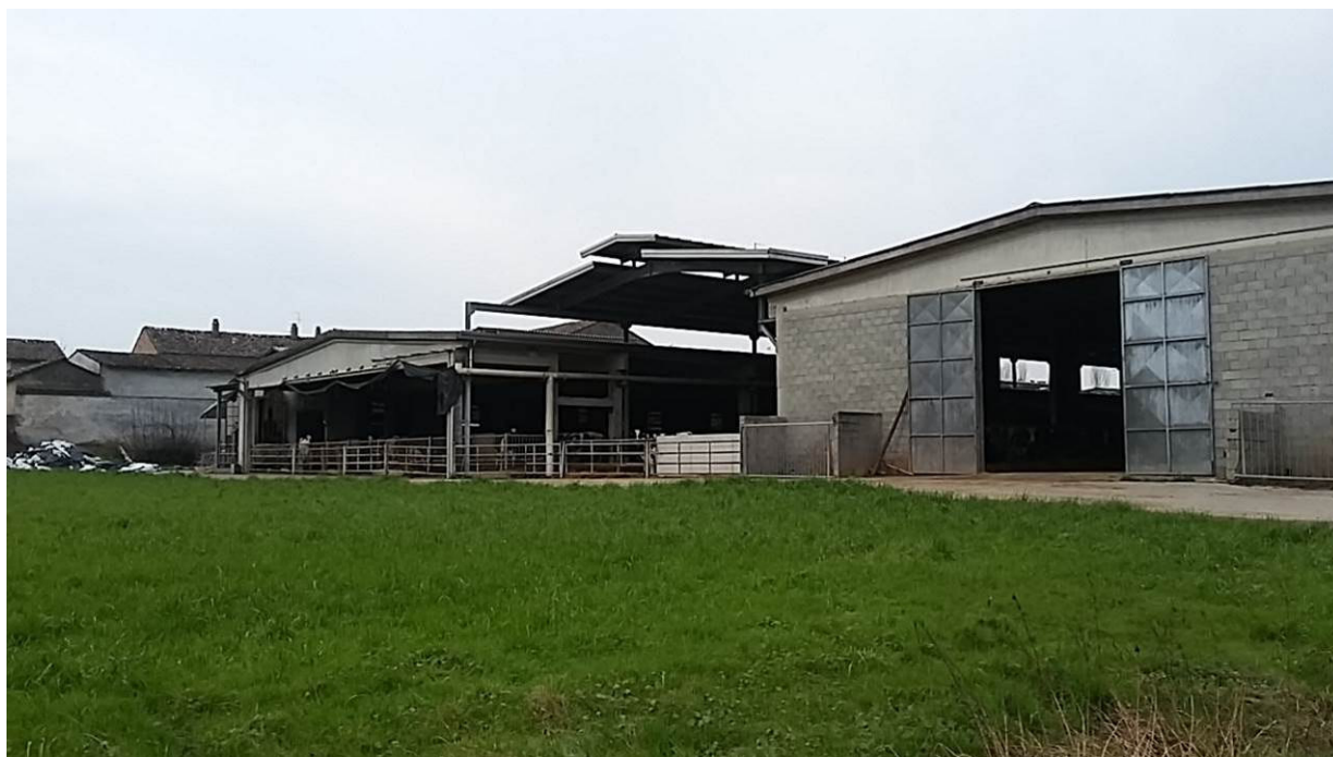
Fig. 13 Lato Sud dei due corpi di fabbrica costituenti la stalla e della tettoia di raccordo fra essi
