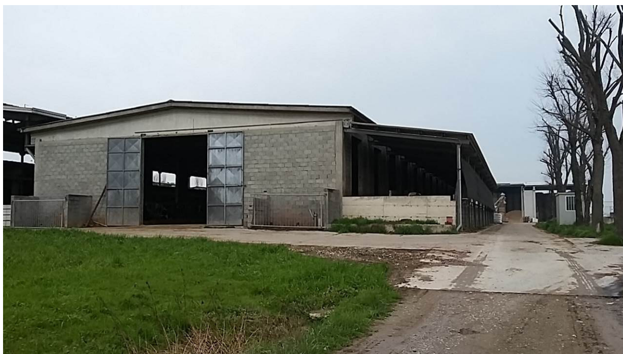
Fig. 12 Lato Sud della stalla e dell'adiacente tettoia
