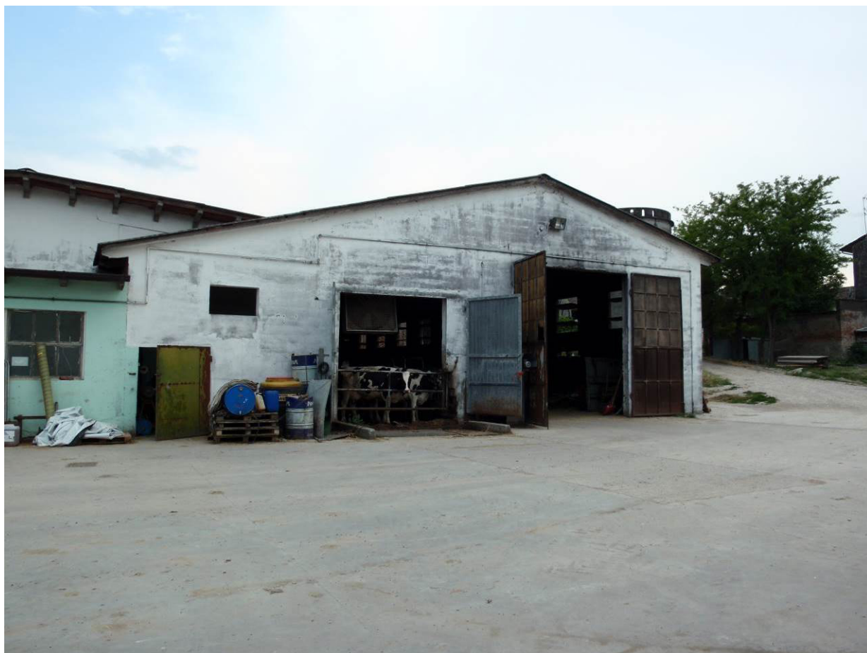
Fig. 3 Vista del lato Nord della stalla ripreso dal centro della proprietà
