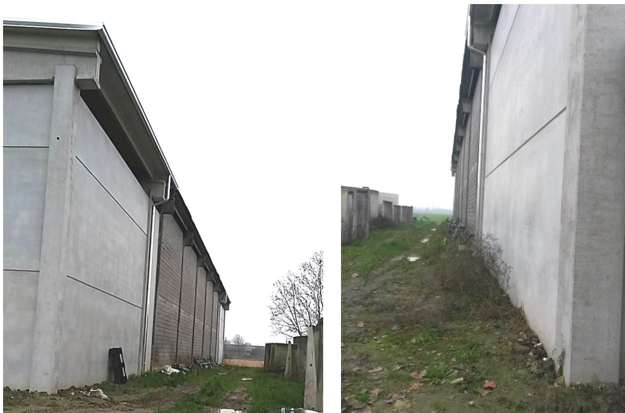
Fig. 4 Viste del lato Nord del capannone a deposito (con relativi recenti ampliamenti Est ed Ovest), con particolare riferimento allo spazio libero intercorrente tra il fabbricato e le vasche circolari
