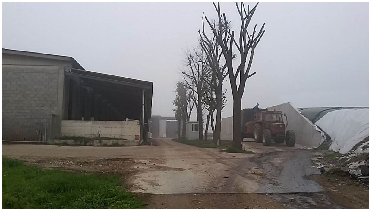
Fig. 11 Stato di fatto presso il lato Sud dell'azienda, in corrispondenza del silo a trincea esistente
