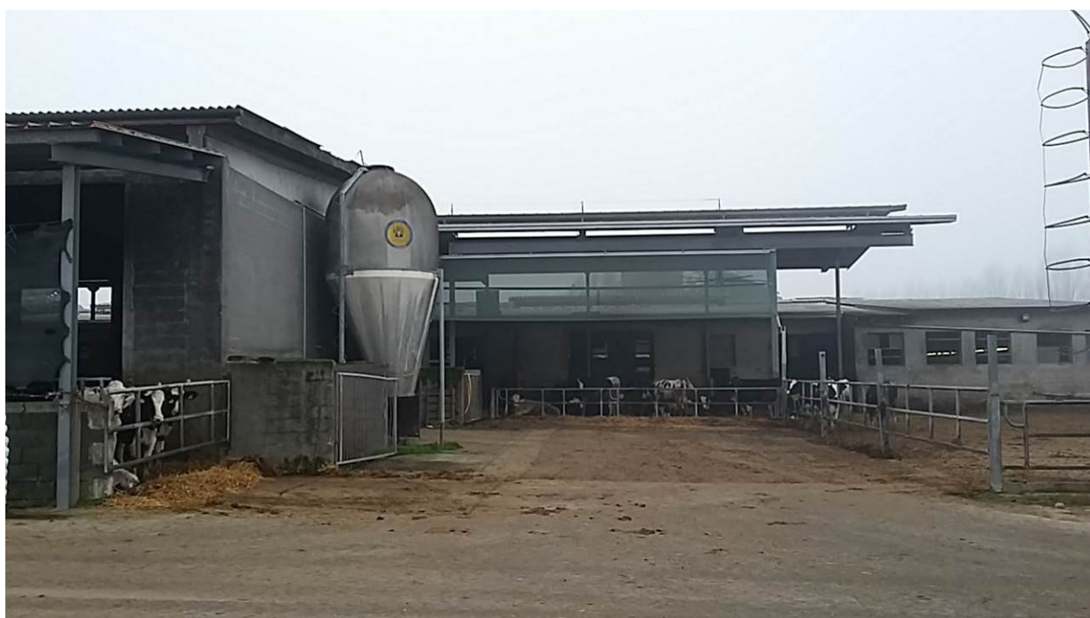
Fig. 8 Vista del lato Nord della stalla e del lato Est della vicina tettoia nei pressi del paddock manzette
