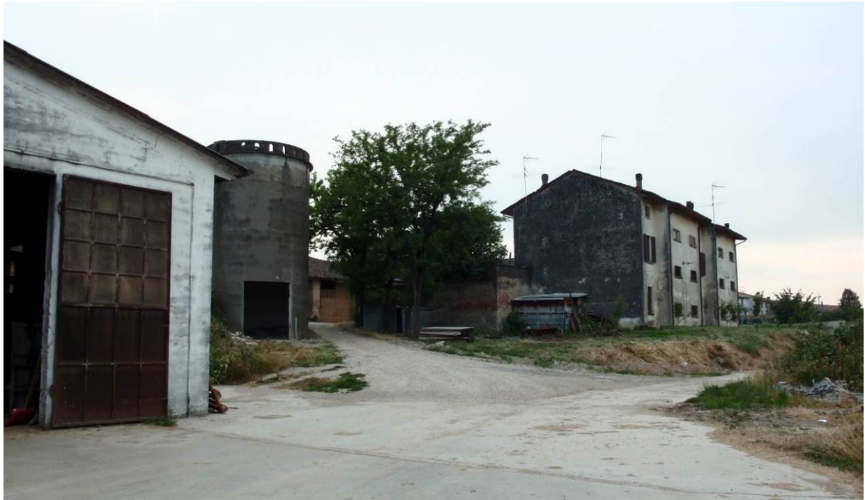
Fig. 1 Ingresso alla proprietà
