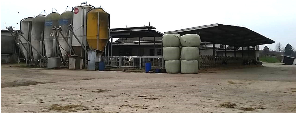
Fig. 5 Vista complessiva della tettoia alimentazione e del paddock manzette ripresi da Est
